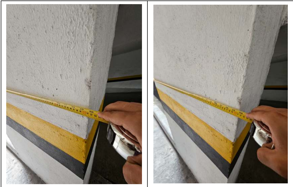
Ilustración 6 Levantamiento de columnas de concreto TP2 y TP3
