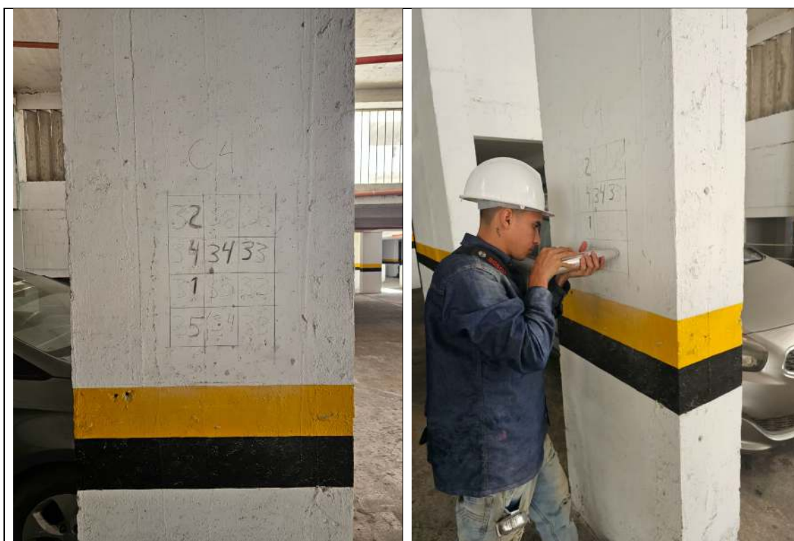
Ilustración 18 Realización del ensayo de índice esclerómetro en columna 4
