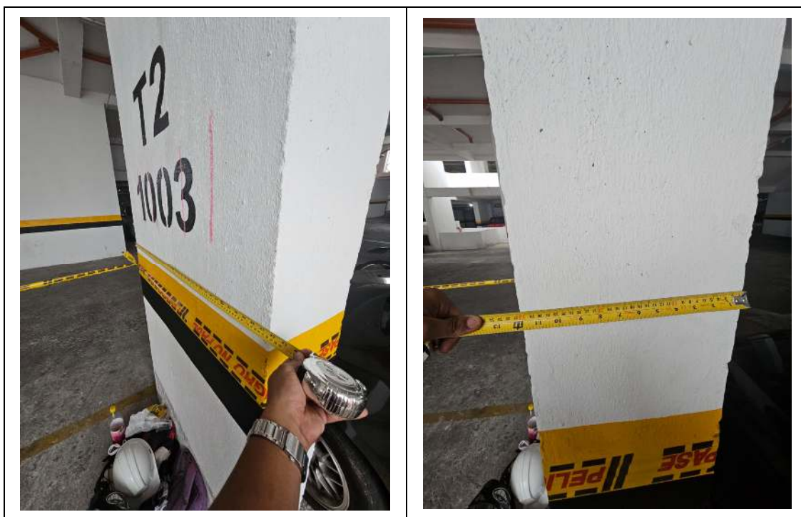
Ilustración 5 Levantamiento de columnas de concreto TP1
