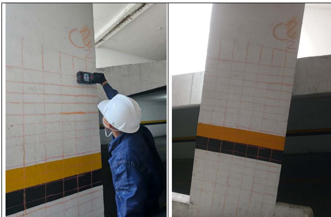
Ilustración 27 Ensayo de ferro-scanner en columna 2
