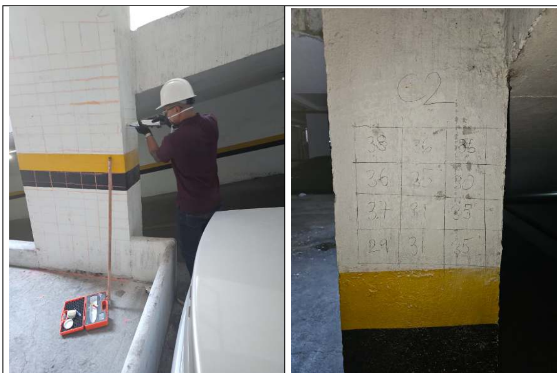
Ilustración 16 Realización del ensayo de índice esclerómetro en columna 2
