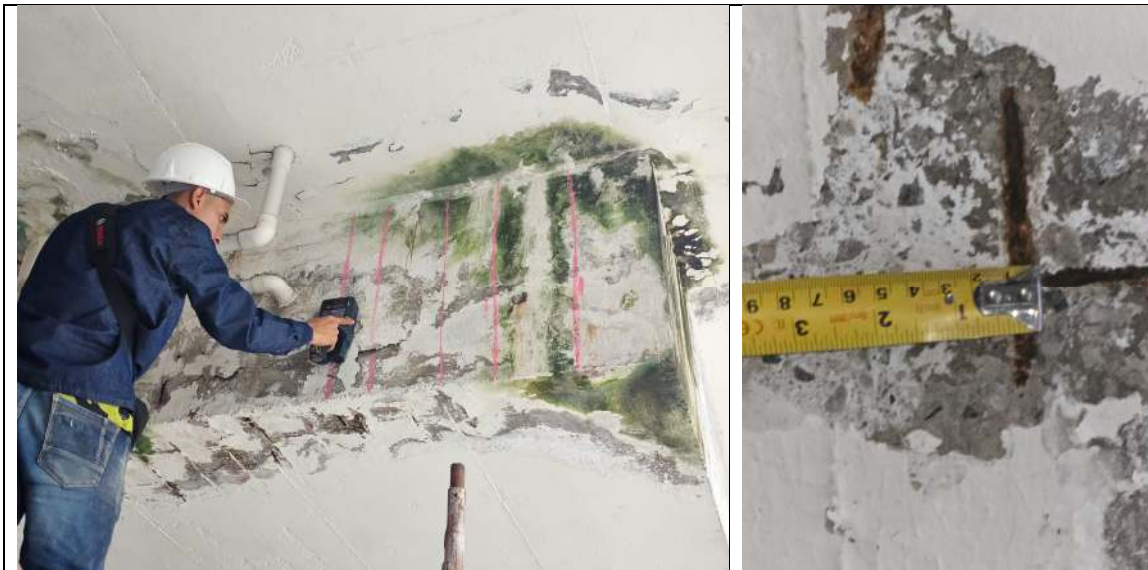
Ilustración 36 Ensayo de ferro-scanner en piscina niños
