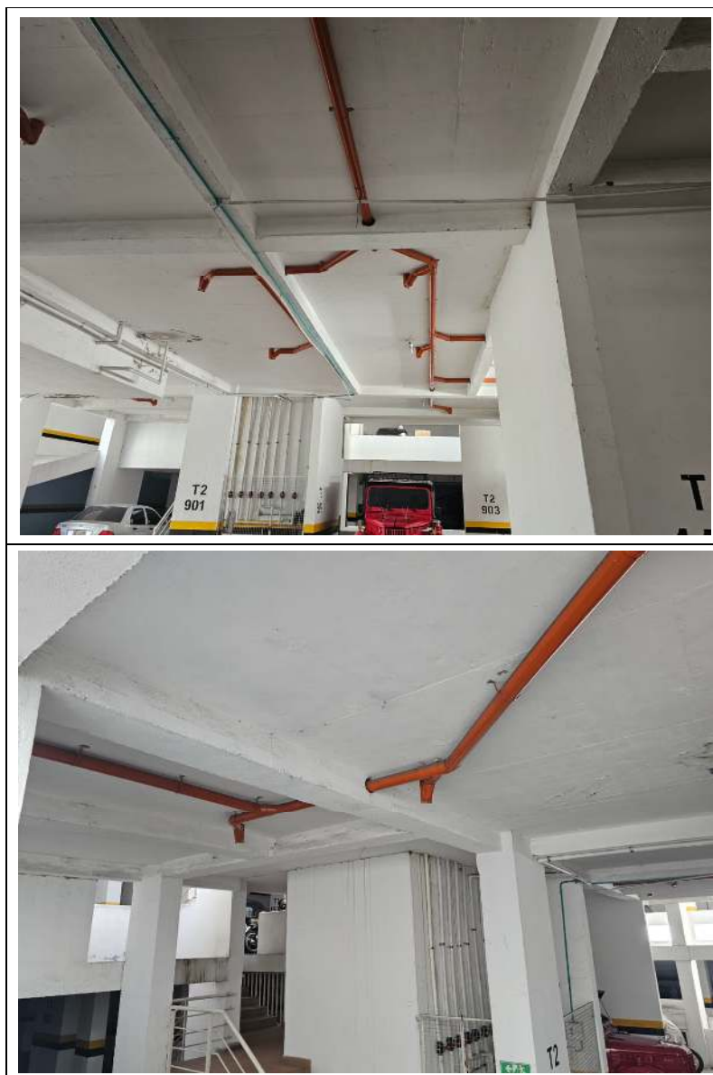
Ilustración 8 Levantamiento de vigas estructurales
