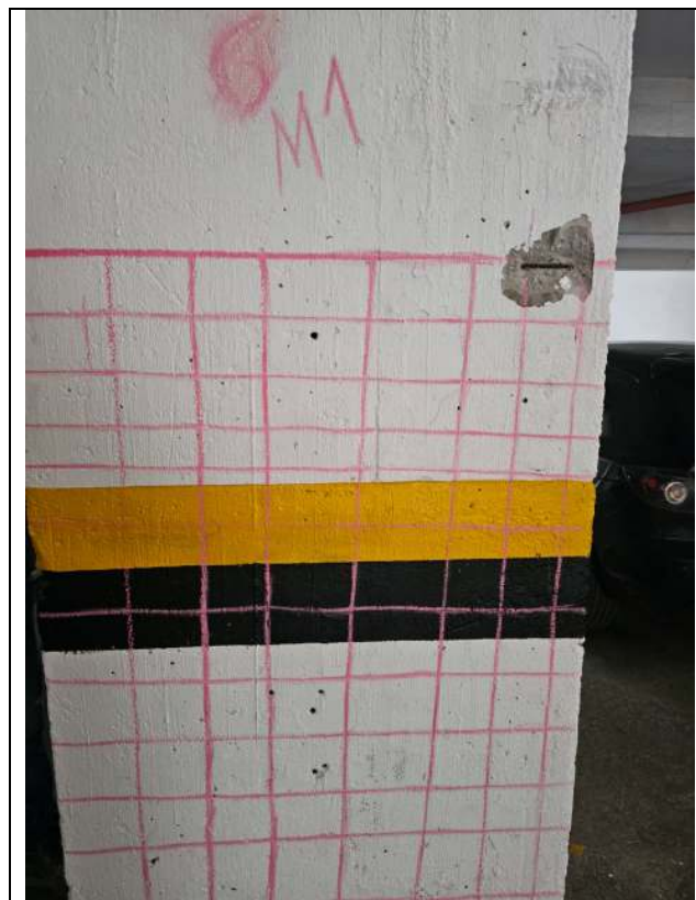
Ilustración 33 Ensayo de ferro-scanner en Muro 1
