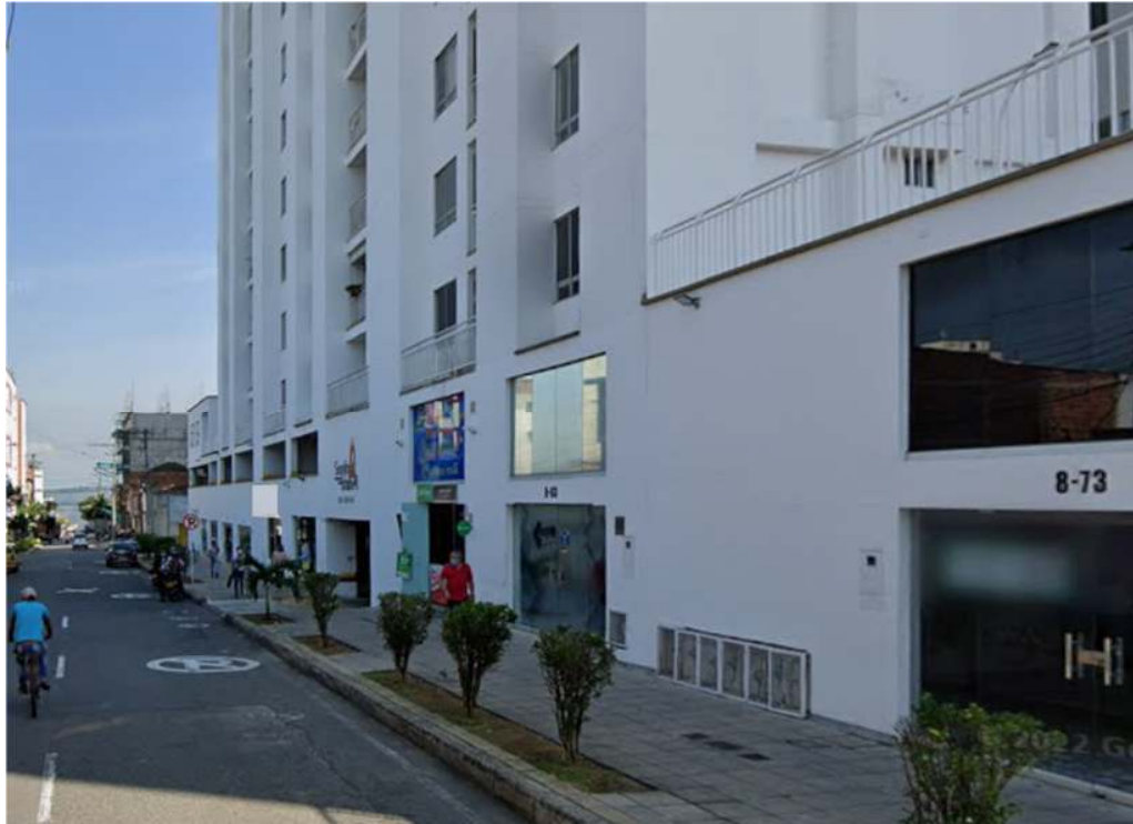
CONDominio SANTA ISABEL, MUNICIPIO DE BUCARAMANGA, DEPARTAMENTO DE SANTANDER.
