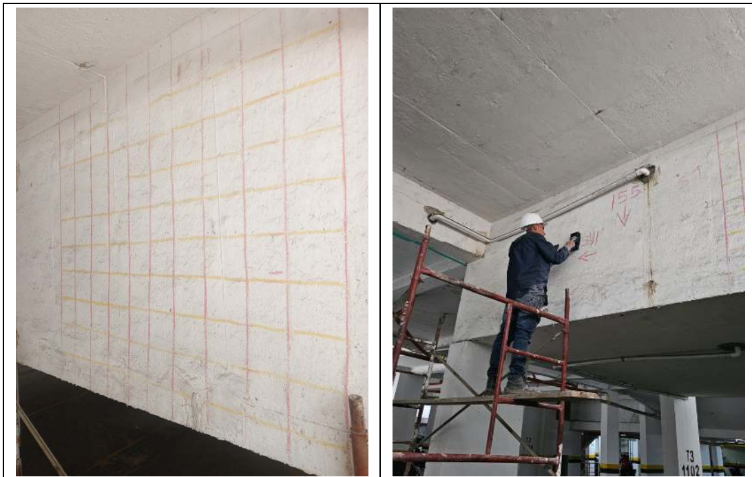
Ilustración 39 Ensayo de ferro-scanner en piscina adultos
