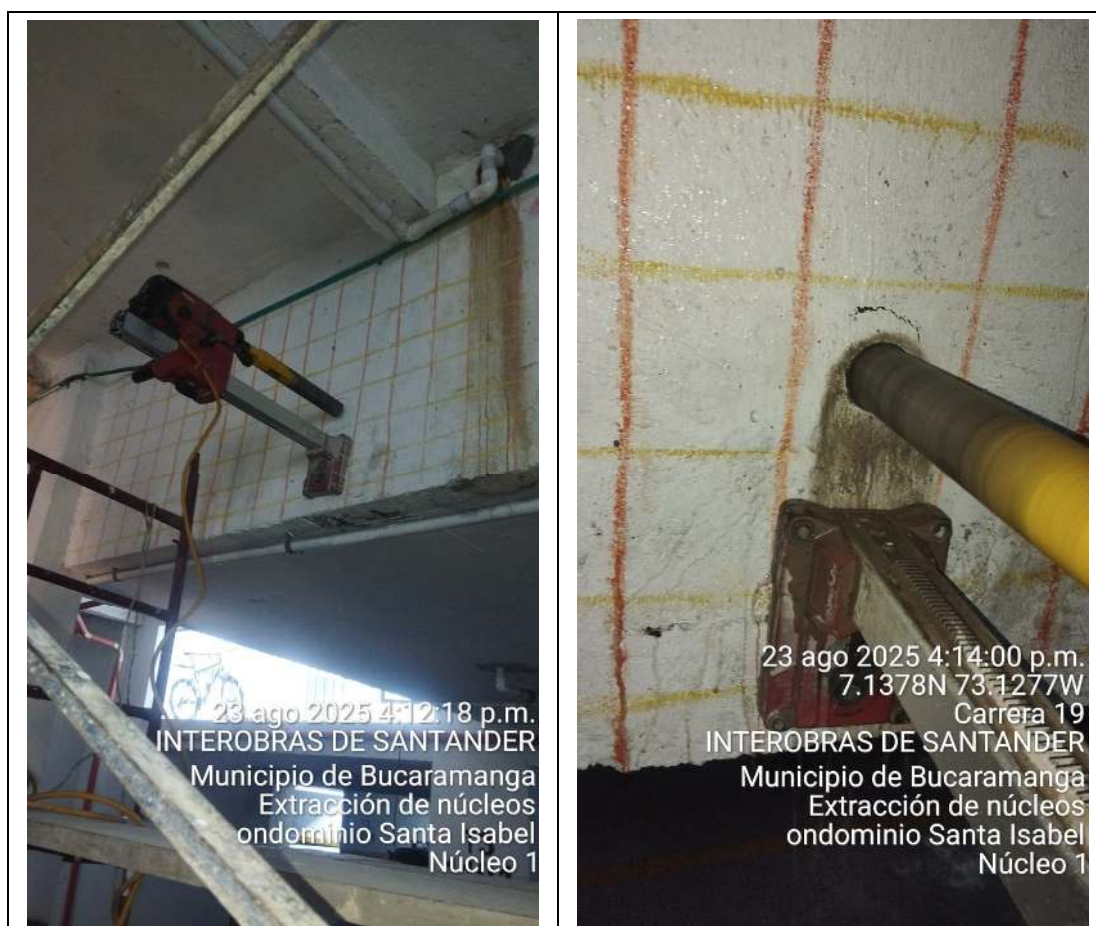
Ilustración 42 Extracción de nucleo #1 en piscina adultos.
