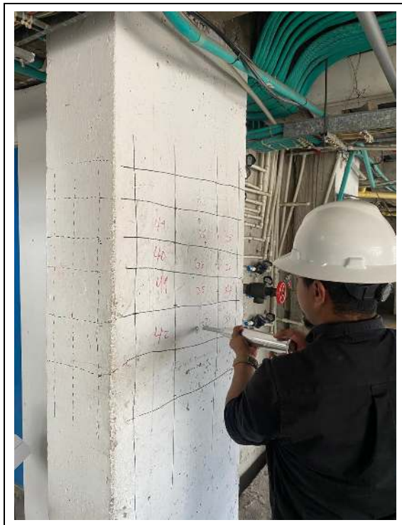
Ilustración 14 Ejecución Lectura con Esclerometro – Ejemplo
