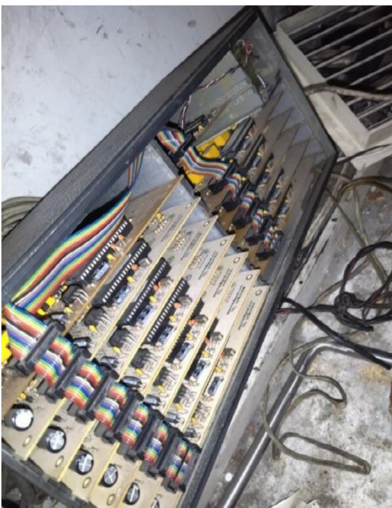
PANEL DE TARJETAS DE ABONADOS-CPU Y LCA4HA
